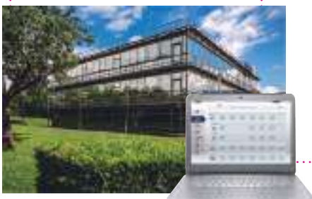
Sistema de gestão de edifícios (BMS)
